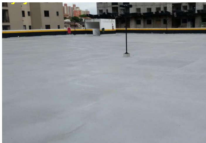
Foto: superfície com aspersão de agregado para superfície antiderrapante Weber.floor AS100
