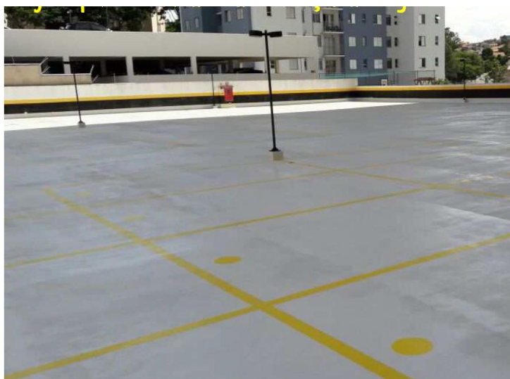
Foto: Aplicada da camada de proteção final Weber.dry pur coat traffic
