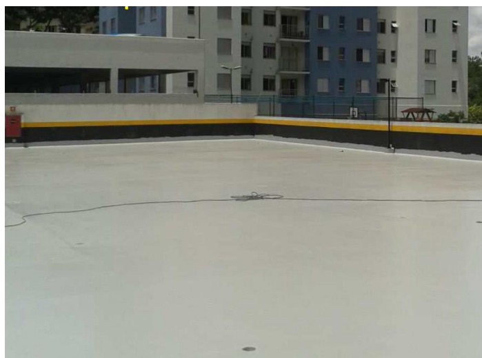
Foto: Aplicação da membrana weber.dry pur seal
