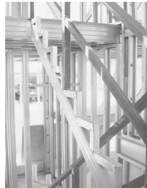
Foto 4.8 - Escada viga caixa inclinada
