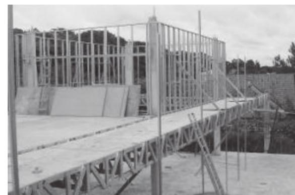
Foto 4.4 - Painéis Masterboard utilizados para laje seca (Fonte: Flasan)
