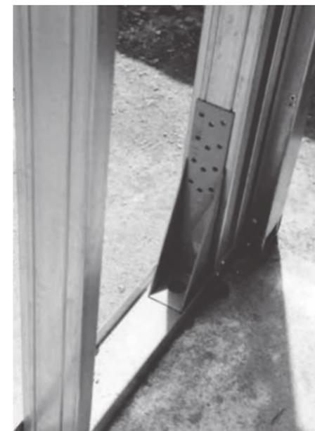
Foto 2.12 - Peça de reforço na ancoragem da estrutura à fundação por meio de barra roscada
