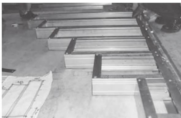
Foto 4.9 - Montagem de uma escada de painéis escalonados
