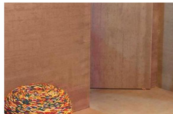
Juntas aparentes para fechamentos internos, sem necessidade de selante entre as juntas.
