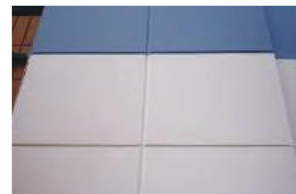
Juntas abertas em fachadas, necessário o uso de **Selamax** entre as juntas para garantir estanqueidade.
