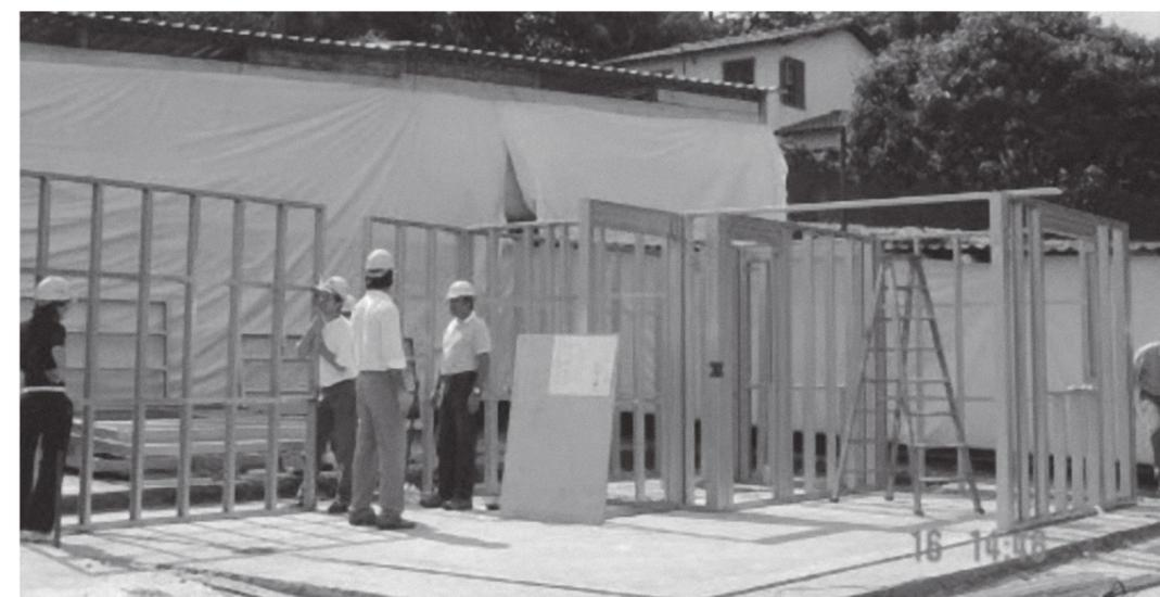
Foto 2.10 - Elementos estruturais como tesouras e painéis são pré-fabricados em oficinas e levados à obra para montagem da estrutura (Fonte: <http://www.aegismetalfaming.com>).
