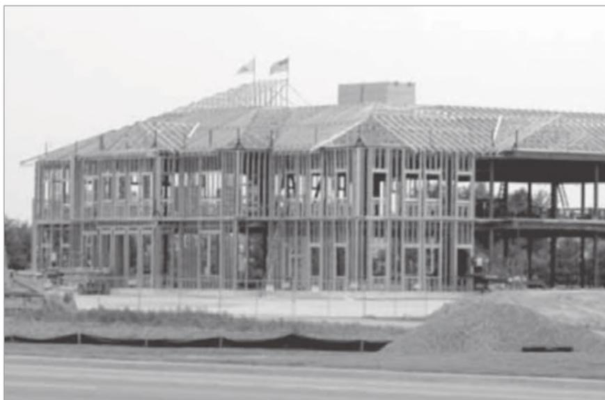
Foto 5.5 - Telhado com interseção de vários planos (Fonte: <http://www.aegismetalframing.com>)
