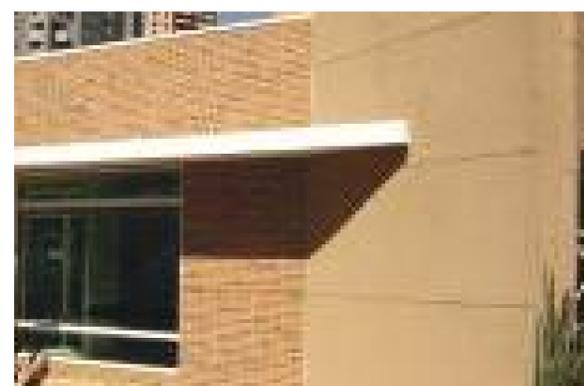
Juntas aparentes em fachadas permitem o uso de mata-juntas ou canaletas metálicas.
