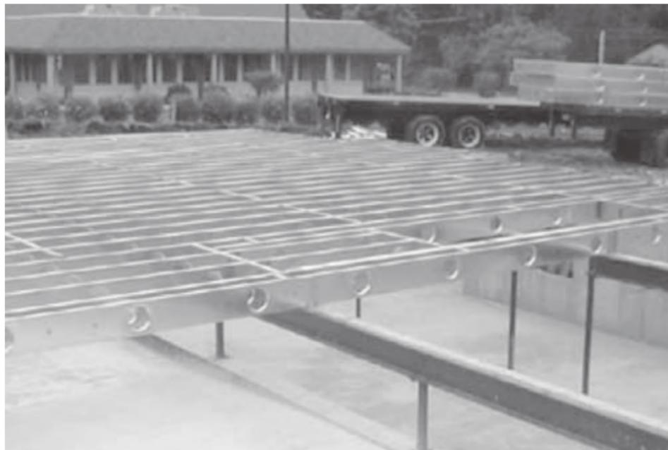
Foto 4.6 - Vigas de piso apoiadas sobre viga principal em aço (Fonte: <http://www.aegismetalframing.com>)
