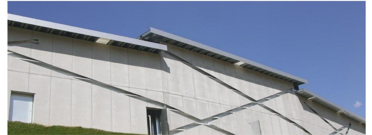
Neste nível, as juntas das placas ficam aparentes e recebem o tratamento recomendado para juntas abertas. As cabeças dos parafusos podem ficar aparentes ou receber duas camadas de Massa para Junta, sendo que, após a primeira camada, é necessário aguardar quatro horas para aplicação da segunda camada. Após a secagem, lixe os pontos de massa para eliminar as saliências e rebarbas. Para paredes coloridas, utilize tinta acrílica à base de água seguindo orientações do fabricante.
