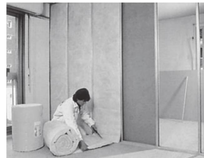
Foto 6.4 - Isolamento termoacústico (Fonte: Isover)
