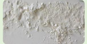
Los muros con el paso del tiempo suelen presentar ligeros agrietamientos, acumulación de humedad por su interior (salitre) y/o pueden contar ya con algún recubrimiento de pintura en mal estado.
