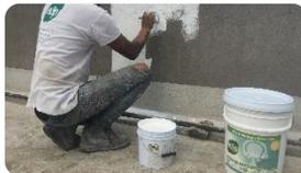
Aplicar la Primera mano del producto con rodillo o brocha sobre la superficie revisando que quede aplicado homogéneamente y deje secar por lo menos 12 horas para aplicar una Segunda mano de a3p UtilWall o a3p Pintura Vinílica para terminar de cubrir toda el área.
