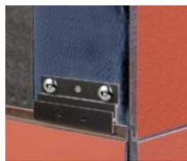
JUNTA DE ESQUINA Fig. 2 ABIERTA CON CINTA PROTECTORA DE EPDM
