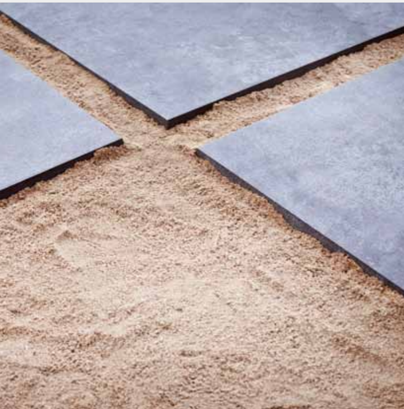
COLOCACIÓN SOBRE ARENA SAND FIXING
