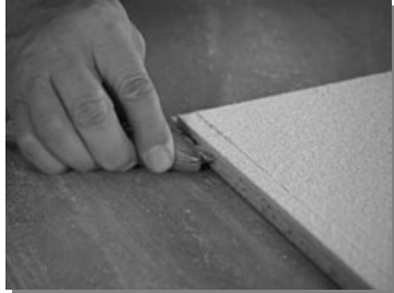
Los plafones de los bordes de orilla tegular pueden requerir cortes de campo. Córdelos con la cara hacia arriba
