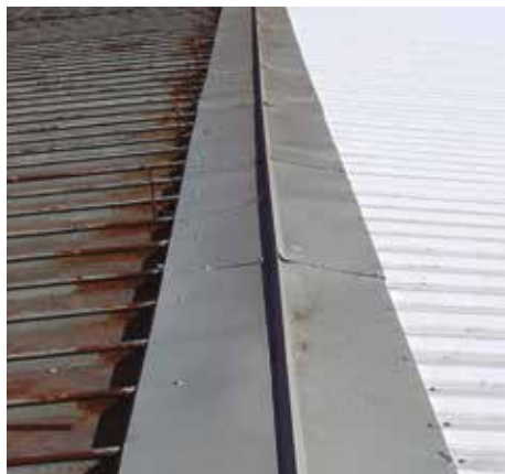
Aplicación de PVC Industrial / Antes y después
