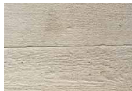
Tendido rascado, aplicado con llana de esponja o de goma dura. Se mantiene la textura de las tablas de encofrado
