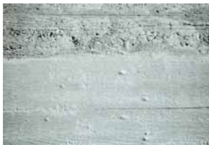
Lechada para cubrir coqueras, aplicada a cepillo, se mantiene la textura basta de las tablas de encofrado
